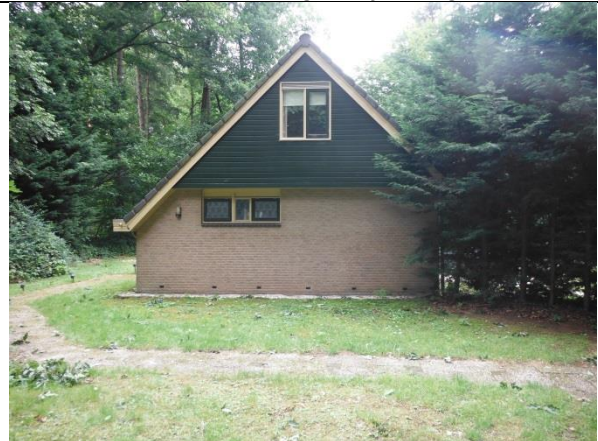
Vanuit noordwestelijke richting nabij boring 7/8
