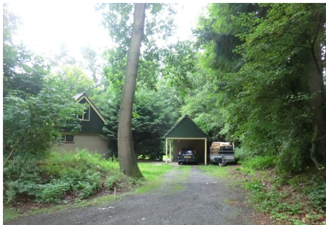
te slopen beheerderswoning en berging
