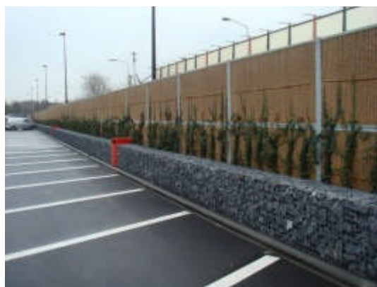
Kokowall geluidsschermbord 3m hoog, geplaatst achter een schanskorf.
