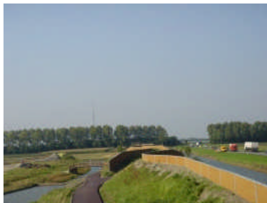
Kokowall geluidsschermbord 1,0m hoogte, geplaatst op verschillende afbuigende taluds
