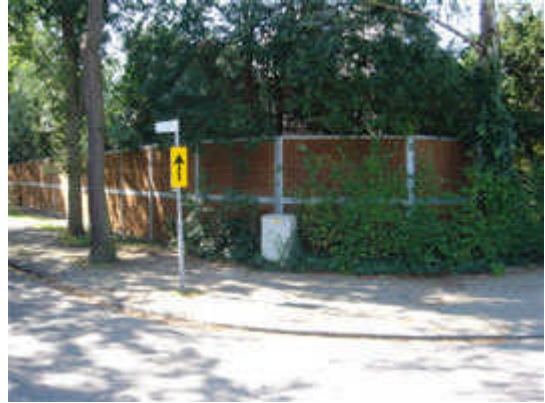
Kokowall geluidschermen 2,5m hoogte, tussen beplanting en bomen geïnstalleerd.
