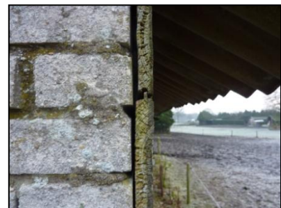
Figuur 11. Ruimte achter betimmering.
