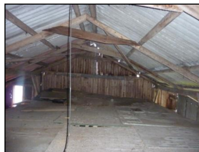
Figuur 10. Zolder grote schuur (verblijfplaats steenuil).
