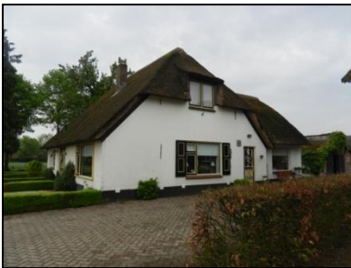
Figuur 3. Woonhuis op locatie.
