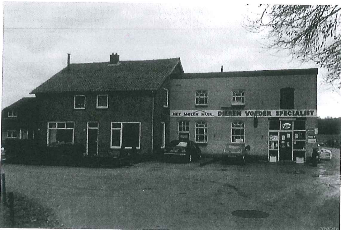
Het voormalige molengebouw, waaraan de gesplitste bedrijfswoning
