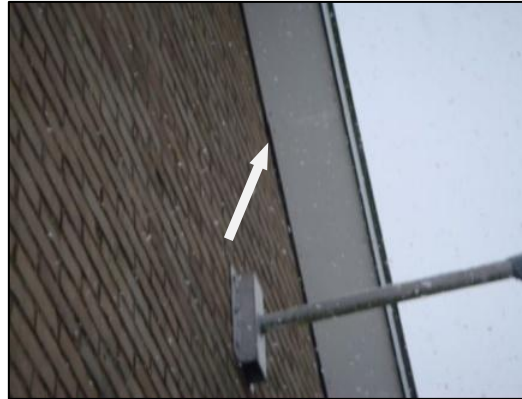
Figuur 3. Ruimte onder de dakrand.
