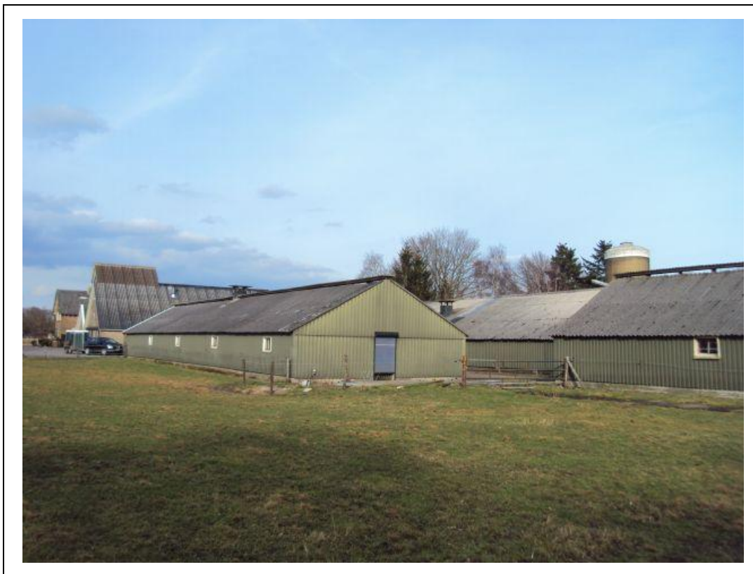
Foto 1. Overzichtsfoto te slopen bebouwing.
