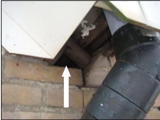
Figuur 2. Openingen in spouwmuur.
