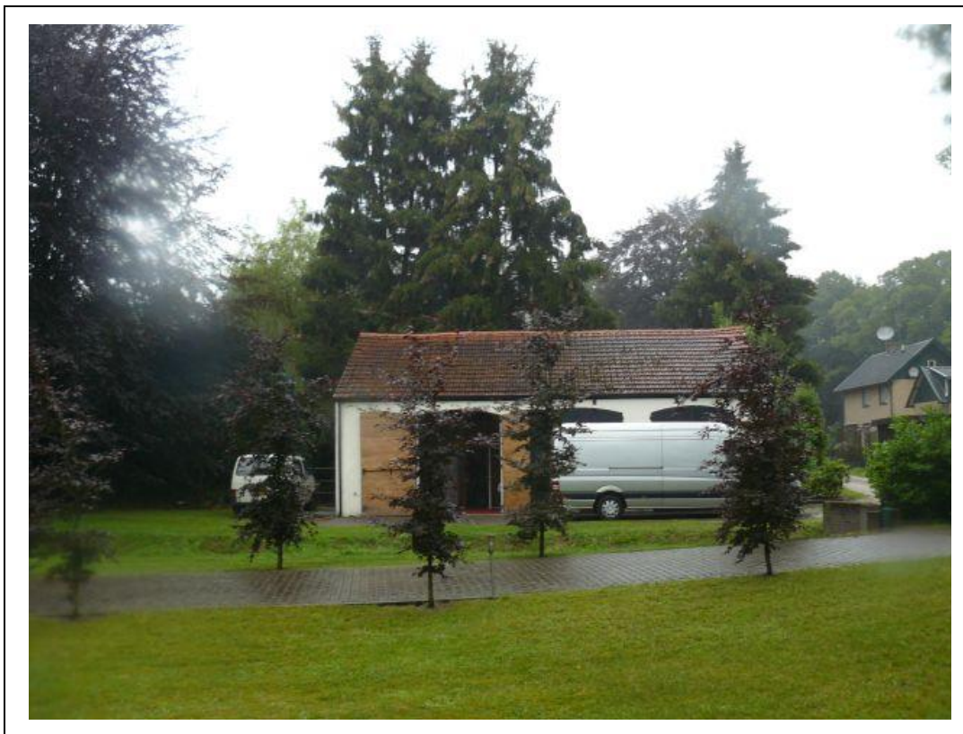
Foto 3. Te renoveren bedrijfsgebouw.
