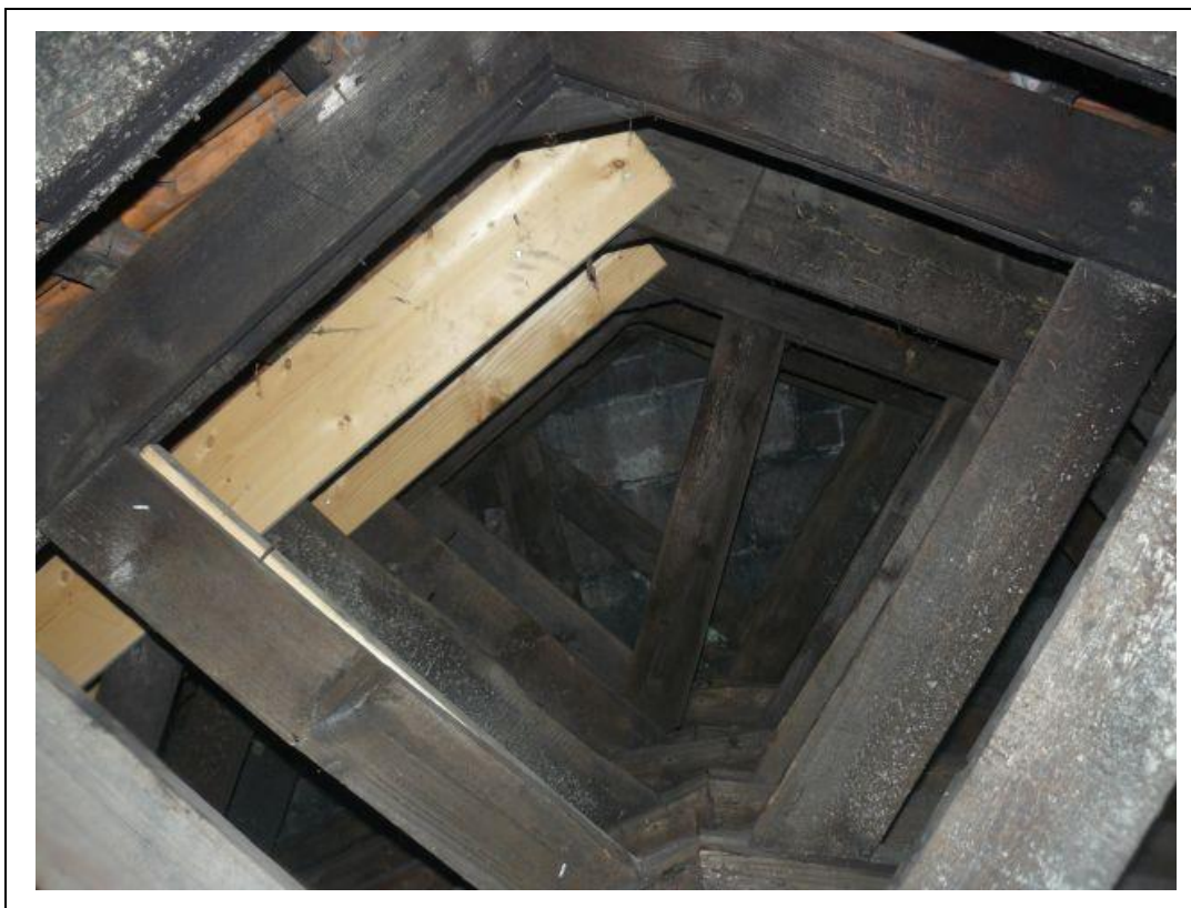
Foto 4. De verborgen ruimte (bedrijfsgebouw) is onderzocht op indicaties van vleermuizen.
