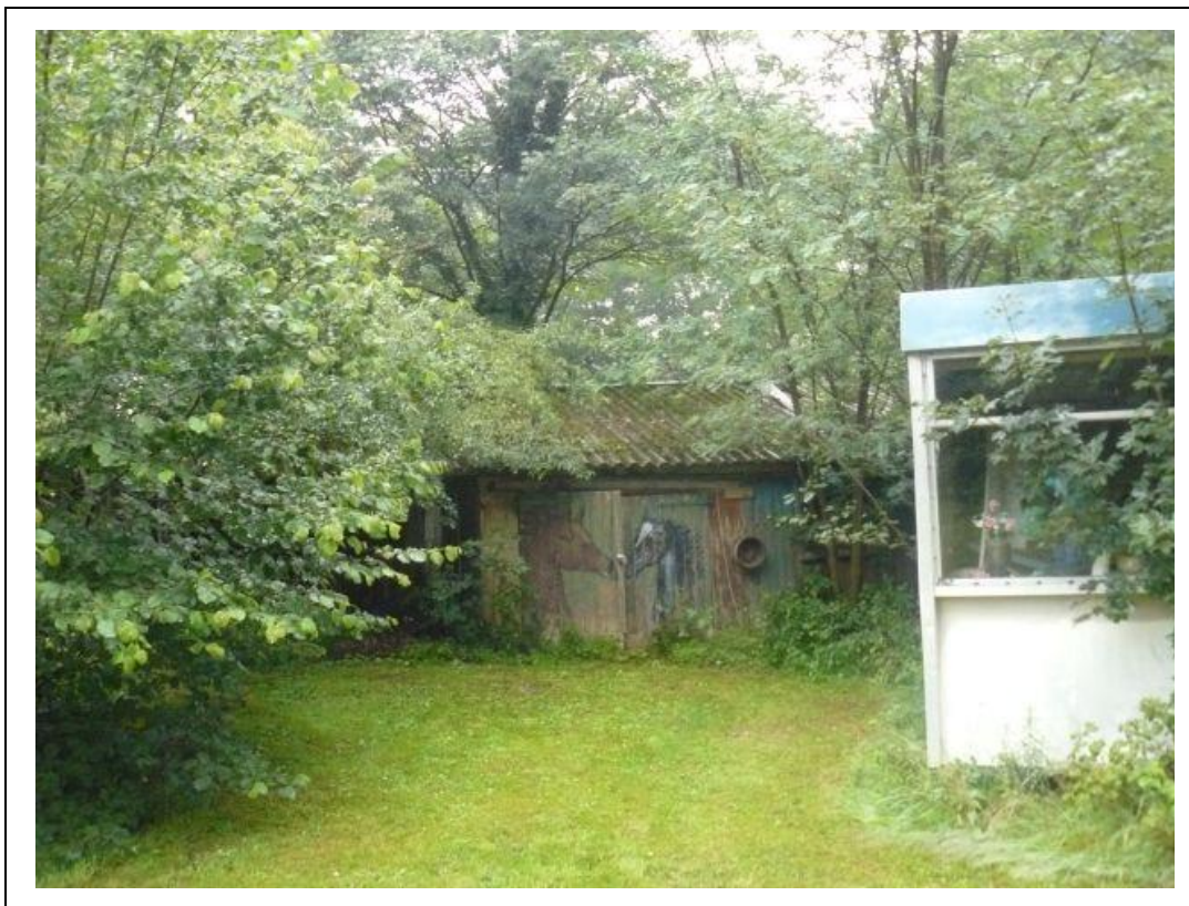
Foto 1. Te slopen paardenstal en stacaravan (rechts).
