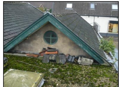
Figuur 5. Detailfoto dak van de bebouwing.
