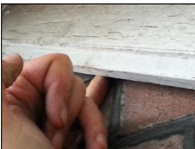
Figuur 9. Ruimte langs dakrand.
