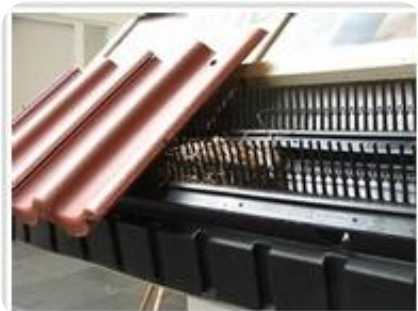
Figuur 13. Voorbeeld vogelvide onder eerste rij dakpannen (Bron: Vogelbescherming).
