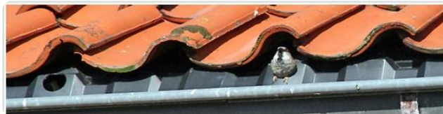
Figuur 14. Vooraanzicht vogelvide onder eerste rij dakpannen (Bron: Vogelbescherming).
