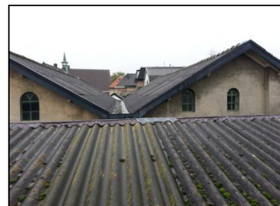
Figuur 11. Overzichtsfoto dichte enkelwandige muren.
