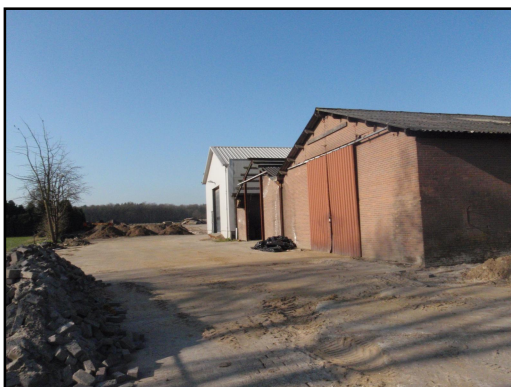
Foto 1 en 2. De te slopen loodsen.
