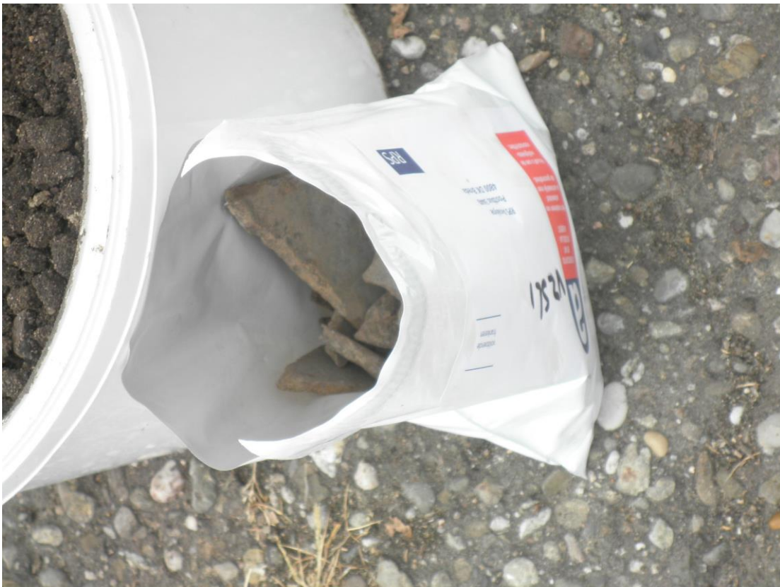
foto 6: asbestverdacht materiaal uit S1
