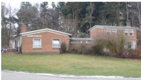
Dienstgebouw aan het Wesselplantsoen.
