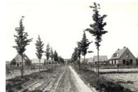
Woningbouw, Elisabethweg ca. 1925-1935 (bron: Coda).
