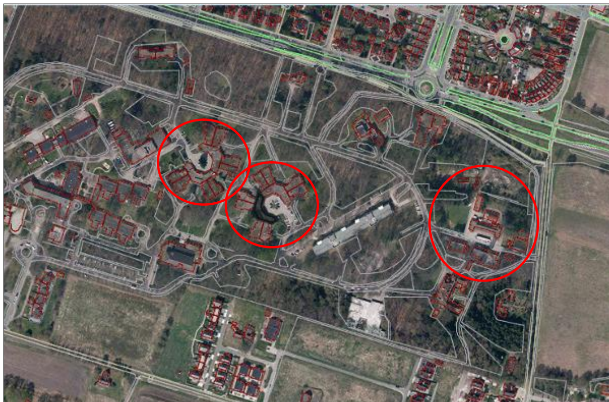
De te slopen gebouwen, aangegeven met rode cirkel (Bron: Gemeente Apeldoorn, 6 september 2010)
