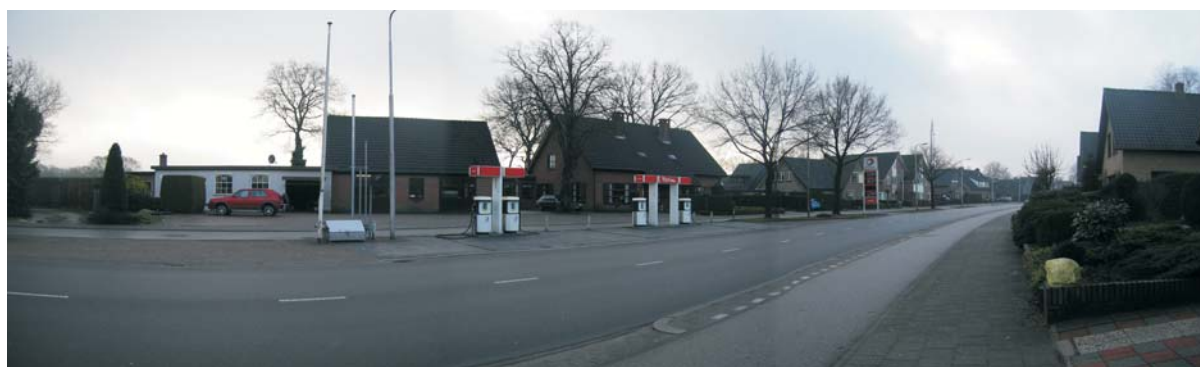
Overzicht garage en tankstation
