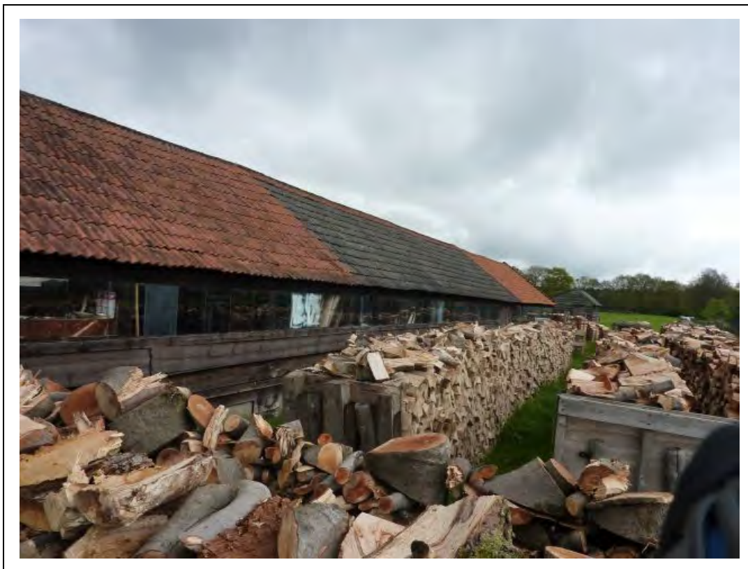
Foto 5. Overzichtsfoto te slopen stallen, zuidelijk deel onderzoekslocatie.
