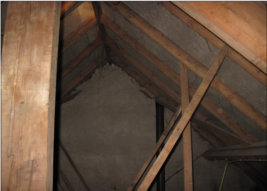
Deel van de zolder van het woonhuis.
