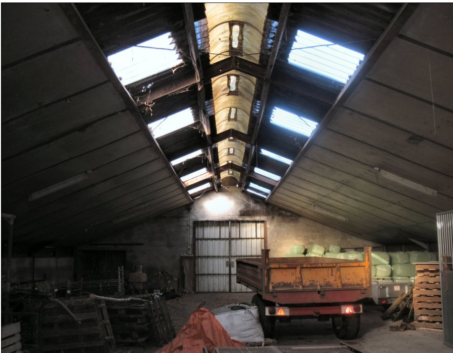
Interieur van dichte deel van gebouw C.
