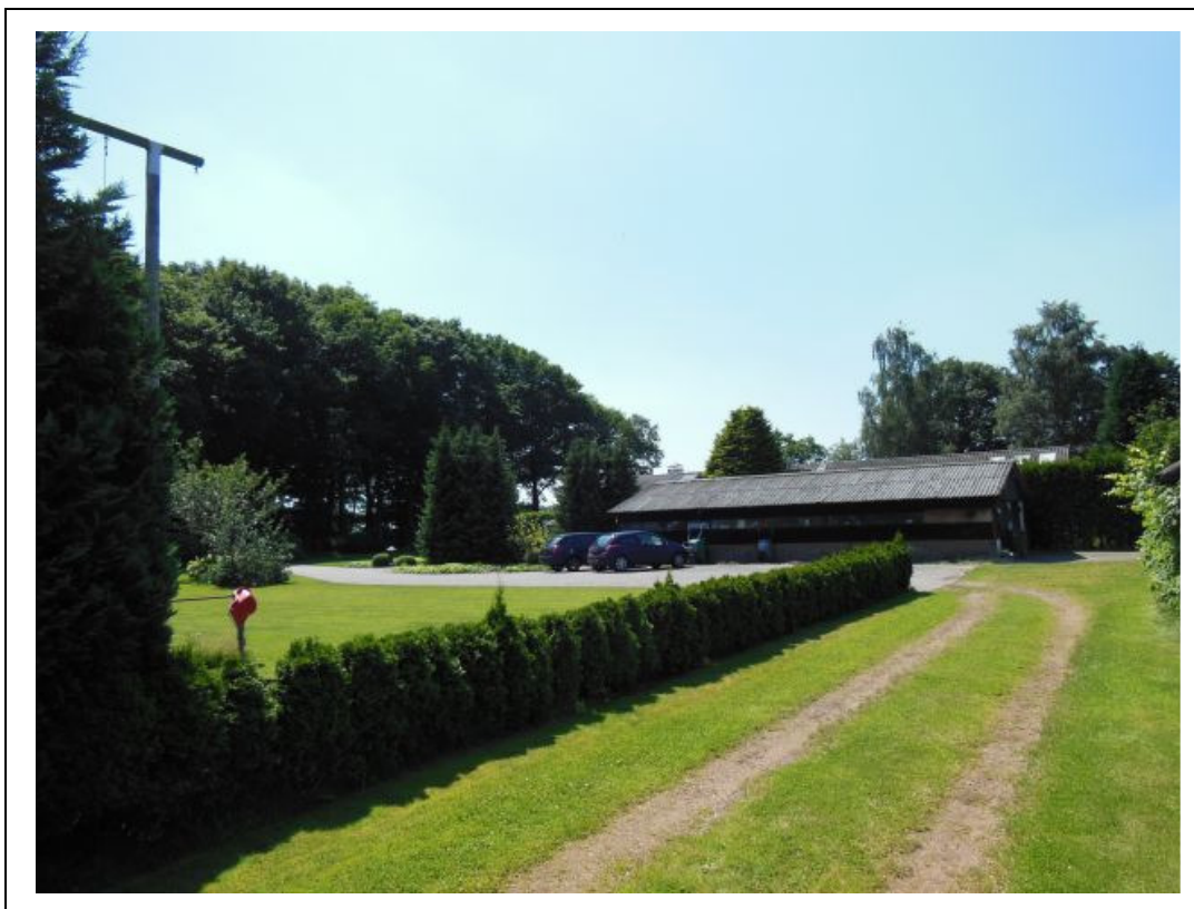
Foto 6. Te handhaven schuur met op achtergrond het woonhuis, buiten onderzoekslocatie.
