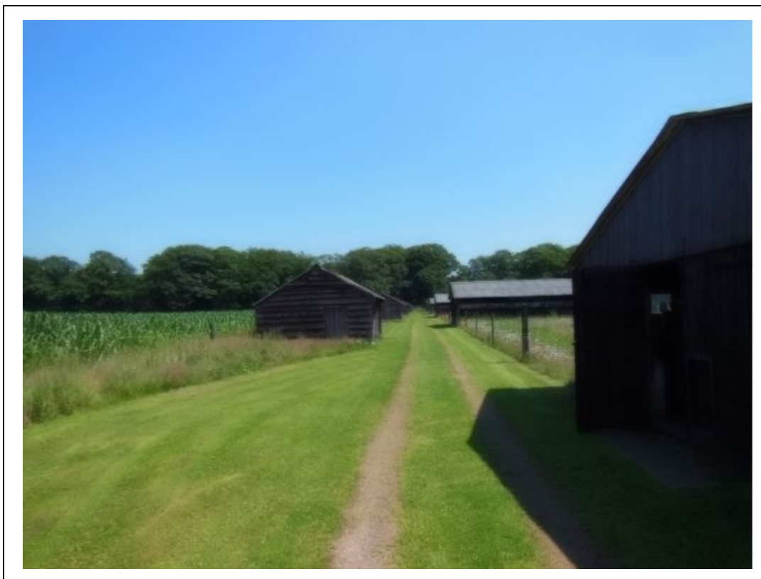
Foto 2. Te slopen schuren op de onderzoekslocatie.
