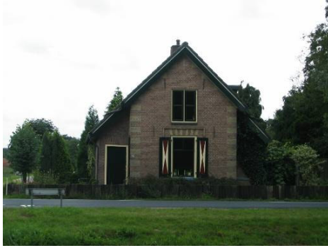
Kanaal Zuid 530, brugwachtershuisje, 2004
