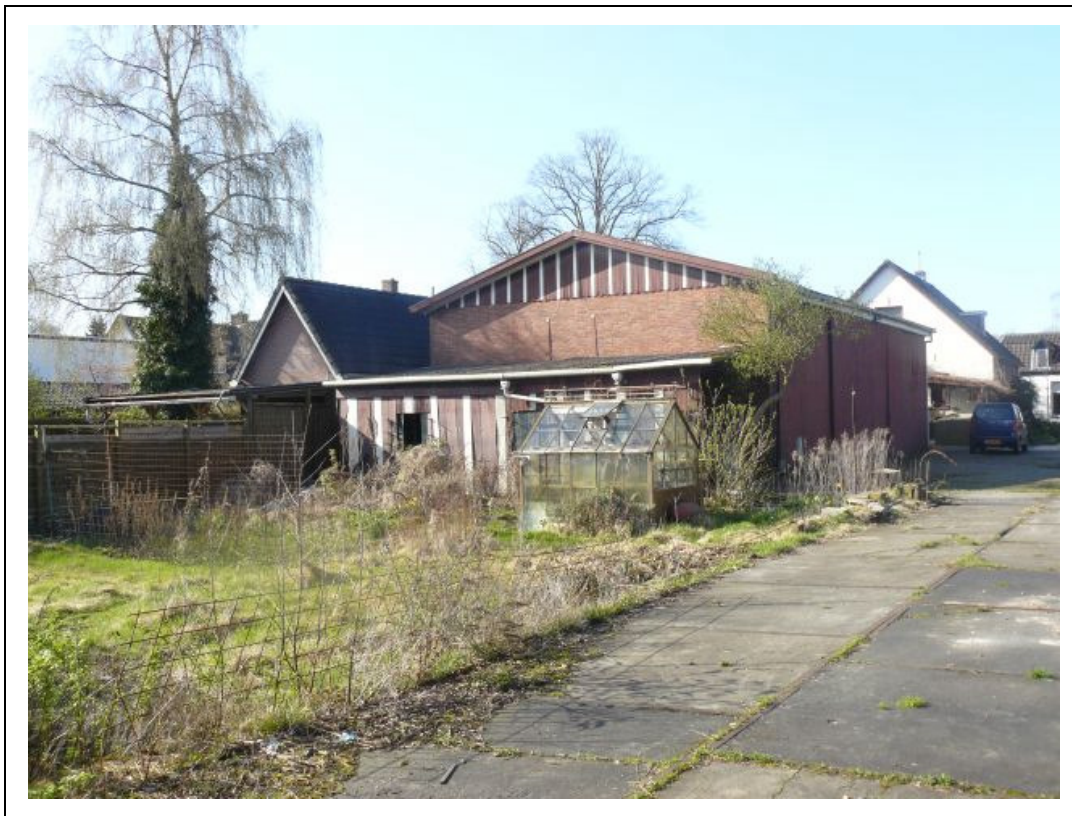
Foto 1. Zicht op de te slopen loods, noordelijk deel onderzoekslocatie.
