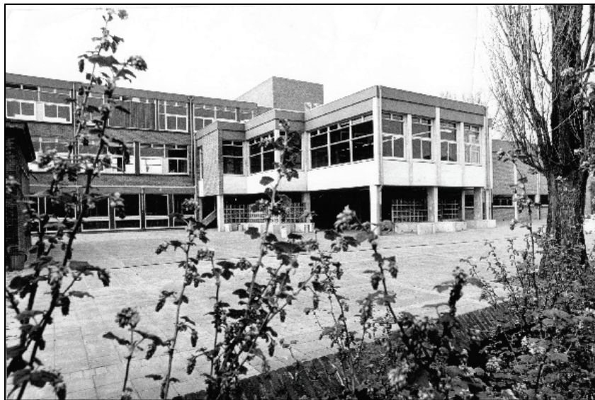
Afb. 3.4.4 – de Christelijke Lagere Landbouwschool aan de Ludgerstraat in aanbouw, maart 1977. bron: Erfgoedcentrum Achterhoek en Liemers, toegang 0101, nummer 0539
