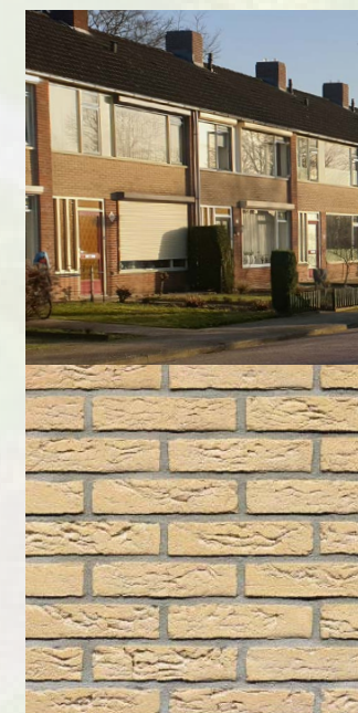
Lichte geelbruine baksteen
