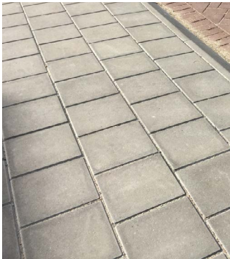
● Trottoirs; grijze betontegels
