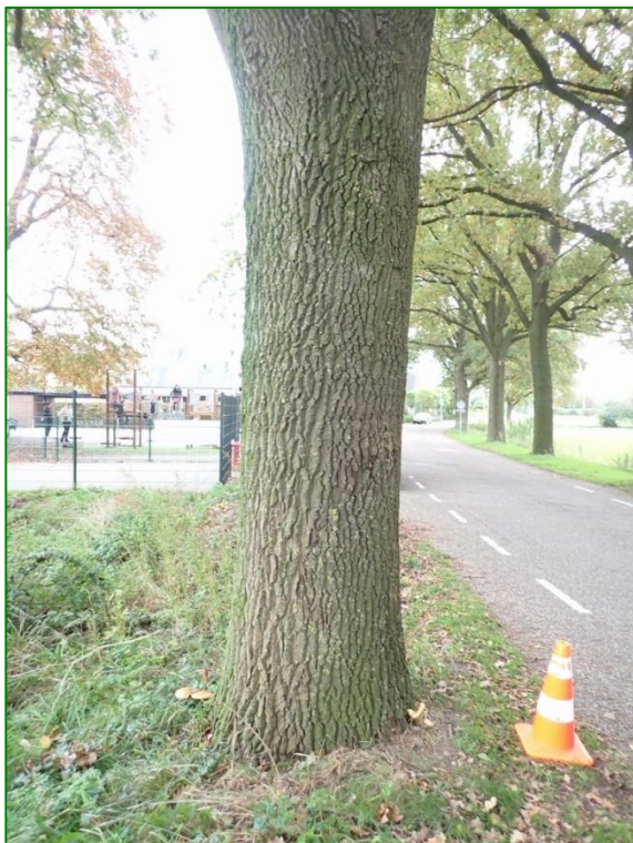
Foto 13: schubbige bundelzwammen aan de zuid- en noordzijde
