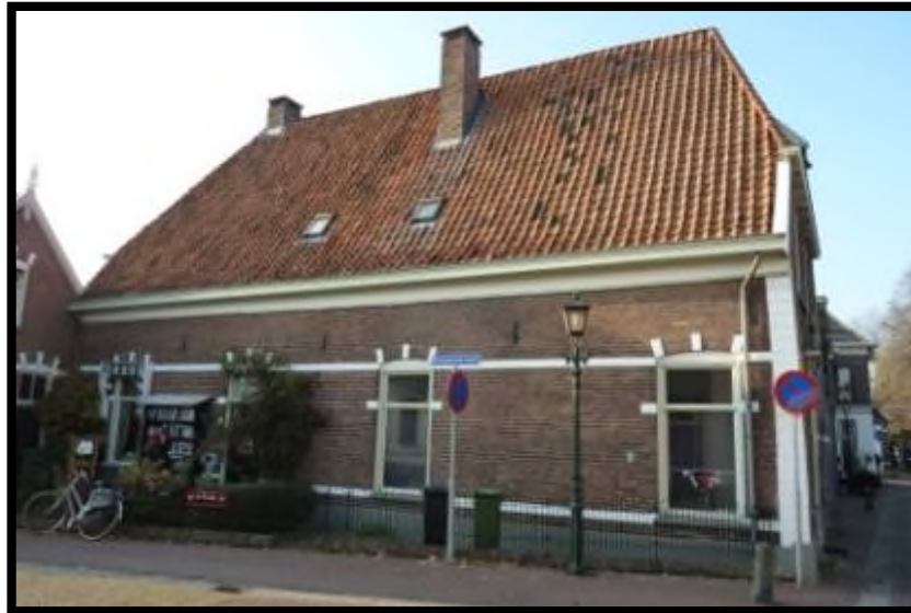
Landstraat 10 zijgevel links
