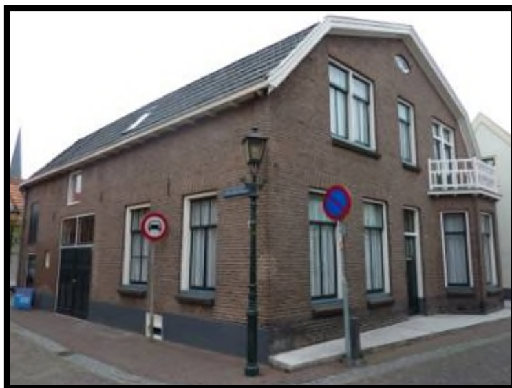
Landstraat 16 zijgevel links
