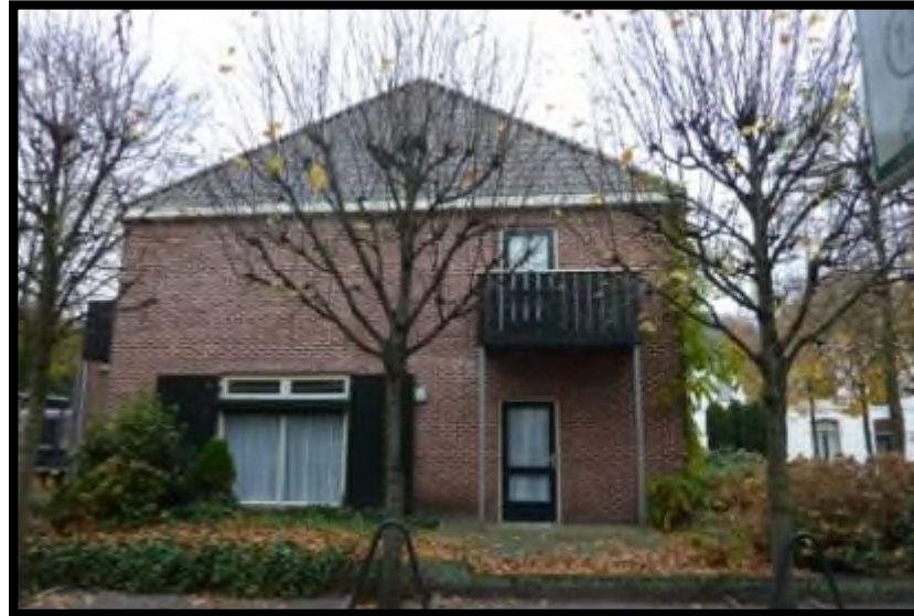
't Zand 28 tm 34 westzijgevel deel 1
