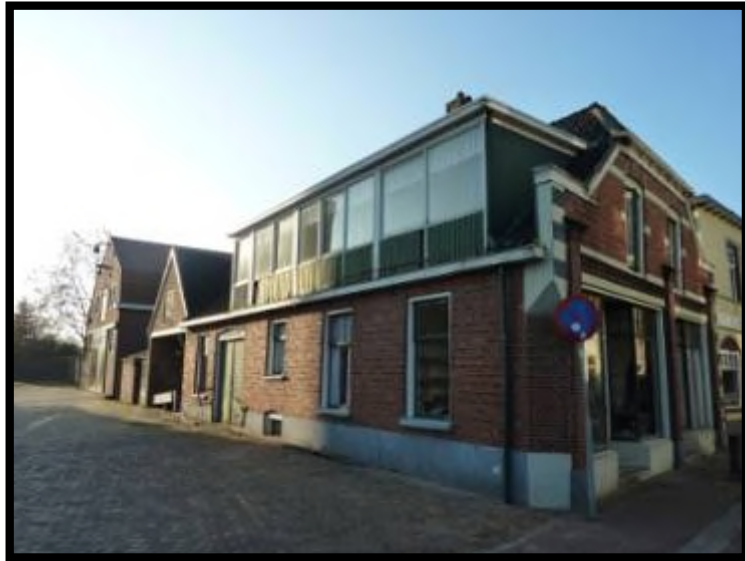
Landstraat 30 zijgevel links totaal
