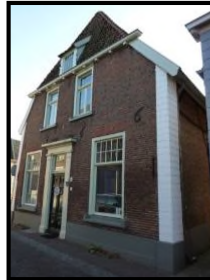
Landstraat 10 zijgevel rechts
