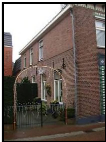
Landstraat 9 zijgevel links
