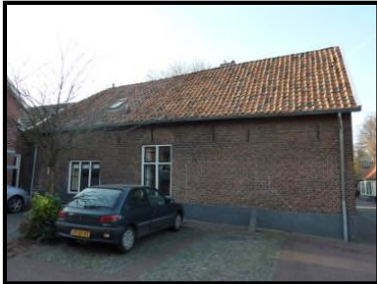
Hozenstraat 8 zijgevel bijgebouw
