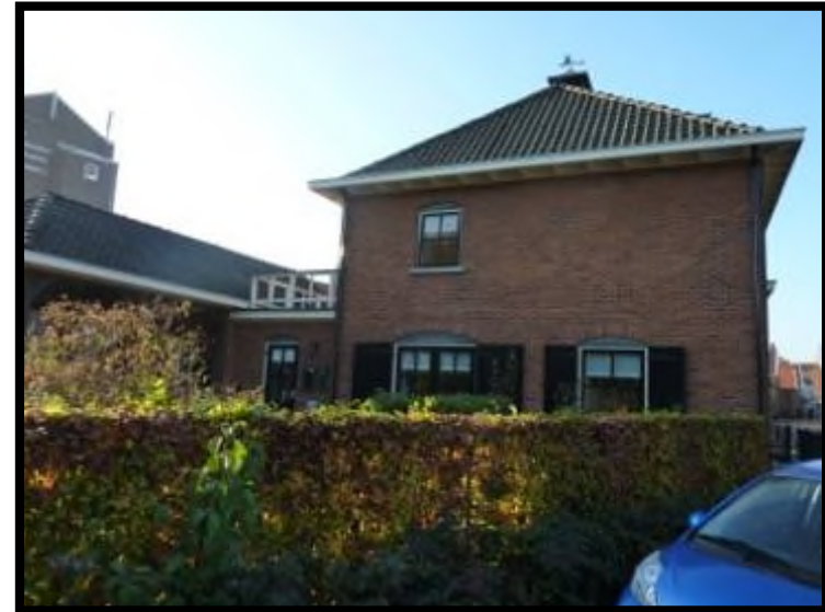
Landstraat 36 zijgevel r
