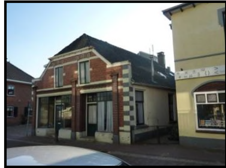
Landstraat 30 zijgevel rechts
