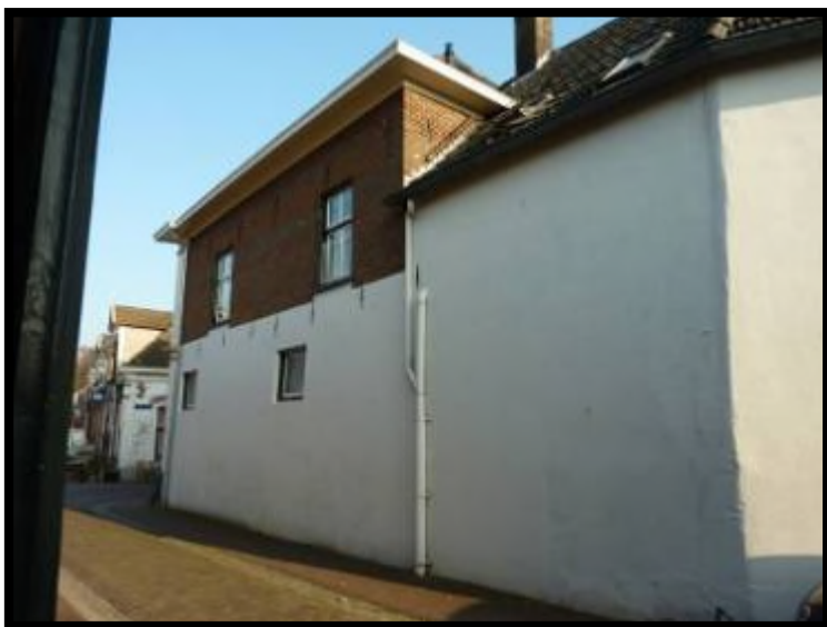
Landstraat zijgevel rechts
