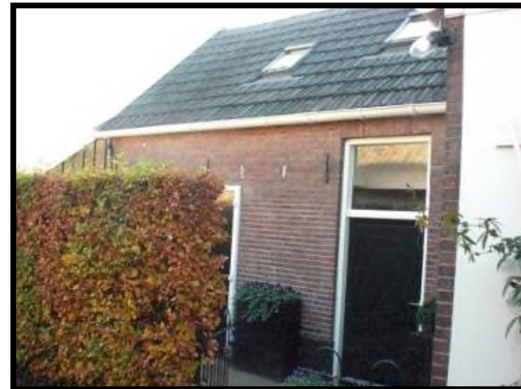
Koppelstraat 13 aanbouw zijgevel
