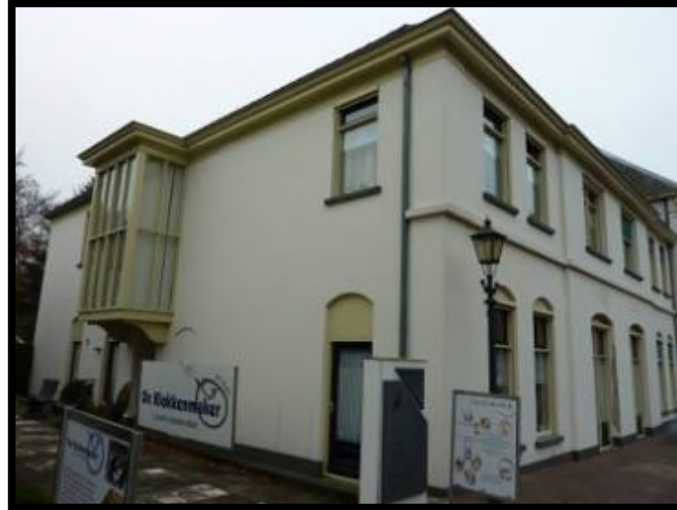
't Zand 23A zijgevel
