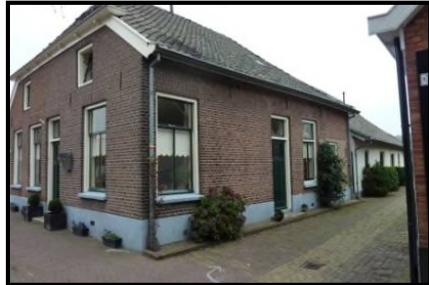
Koppelstraat 11 zijgevel rechts
