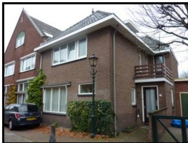
Landstraat 5A zijgevel
