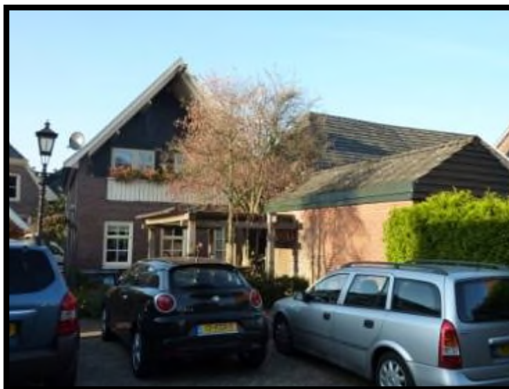
Officierstraat 1A achtergevel
