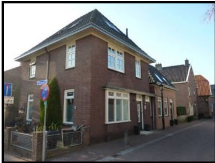
Landstraat 24 zijgevel links
