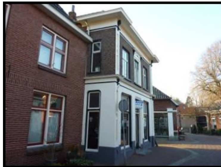
Landstraat 6 zijgevel links
