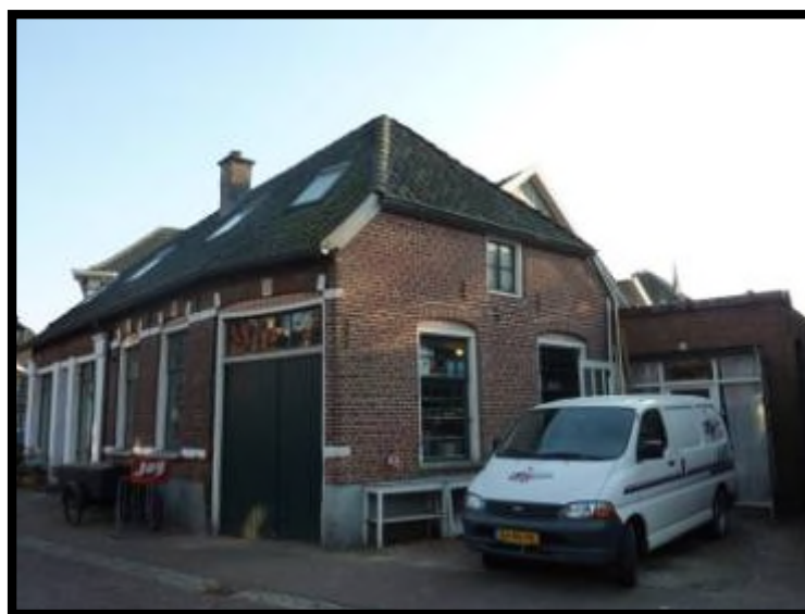
Landstraat 4A zijgevel rechts
