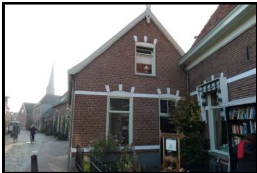
Koppelstraat 4 zijgevel rechts
