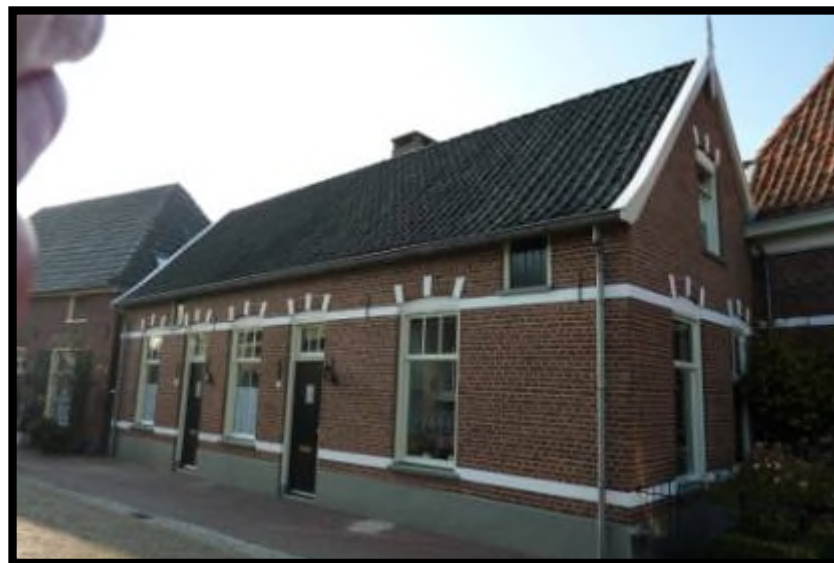
Koppelstraat 4 zijgevel rechts
