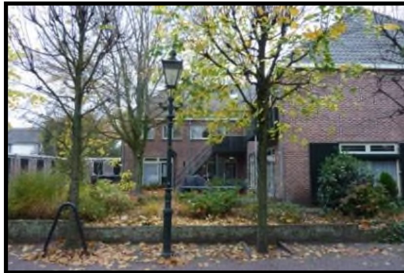
't Zand 28 tm 34 westzijgevel deel 2
