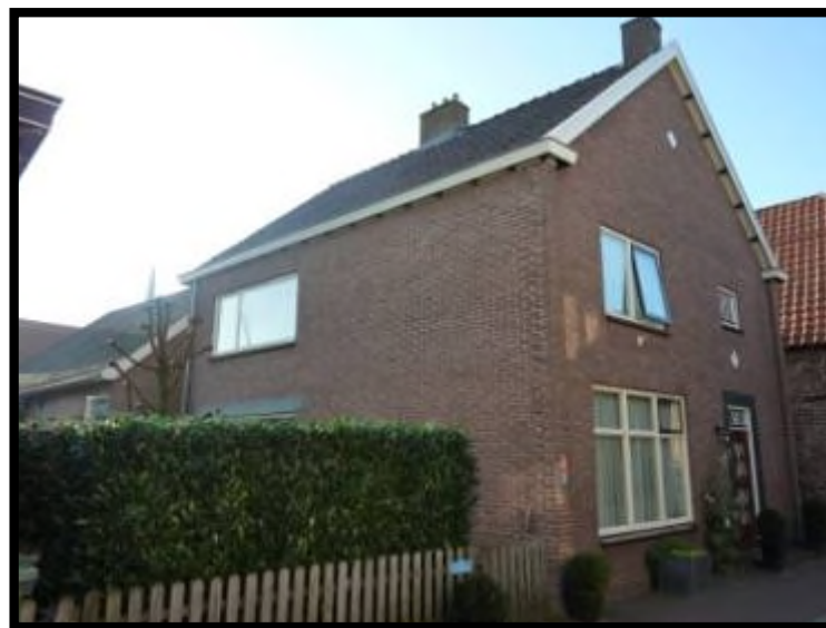
Landstraat 20 zijgevel links
