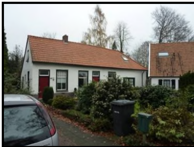
't Zand 19A zijgevel
