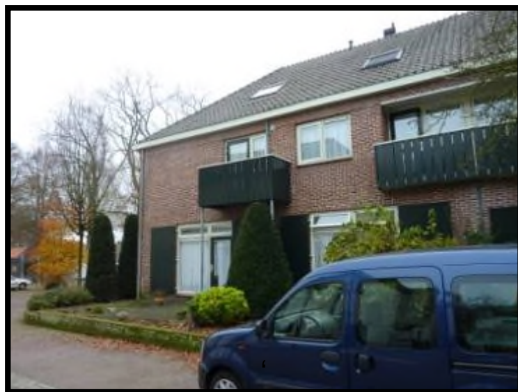
t Zand 26 tm 34 oostzijgevel deel 3
