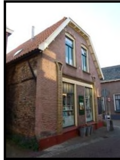
Landstraat 18 zijgevel links
