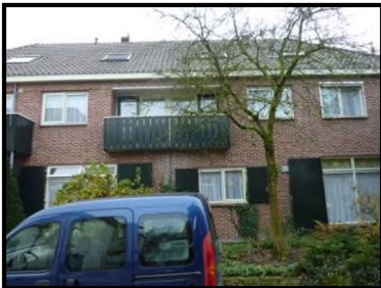
't Zand 26 tm 34 oostzijgevel deel 1
