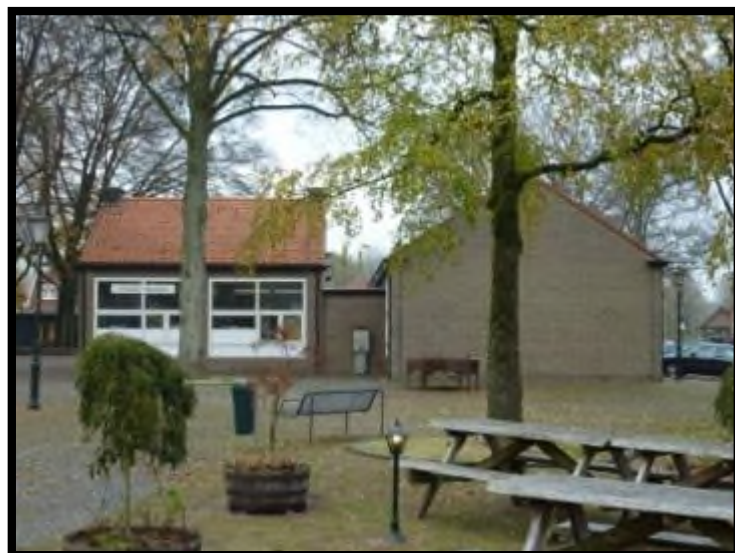
't Zand 25 zuidgevel
