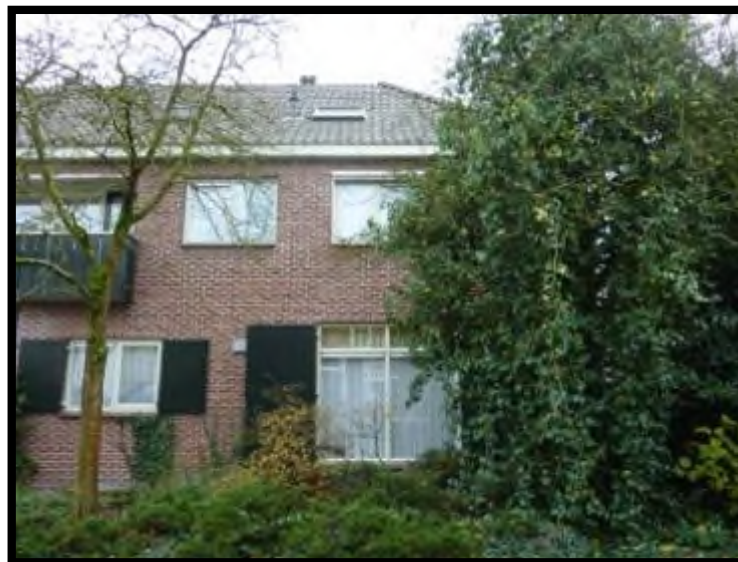
't Zand 26 tm 34 oostzijgevel deel 2
