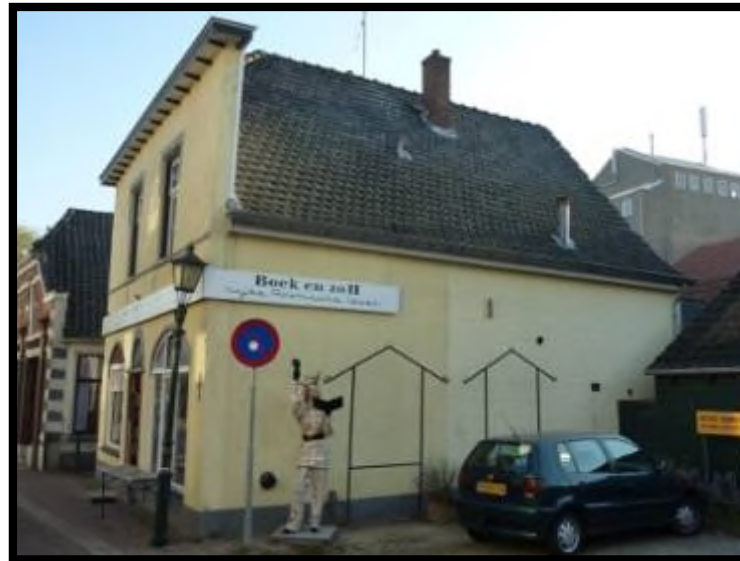
Landstraat 28 zijgevel rechts
