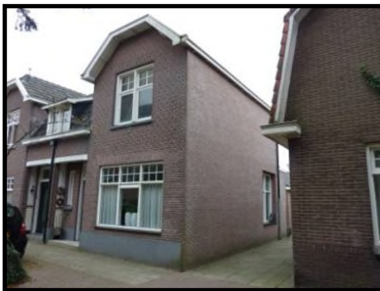
Koppelstraat 17 zijgevel rechts
