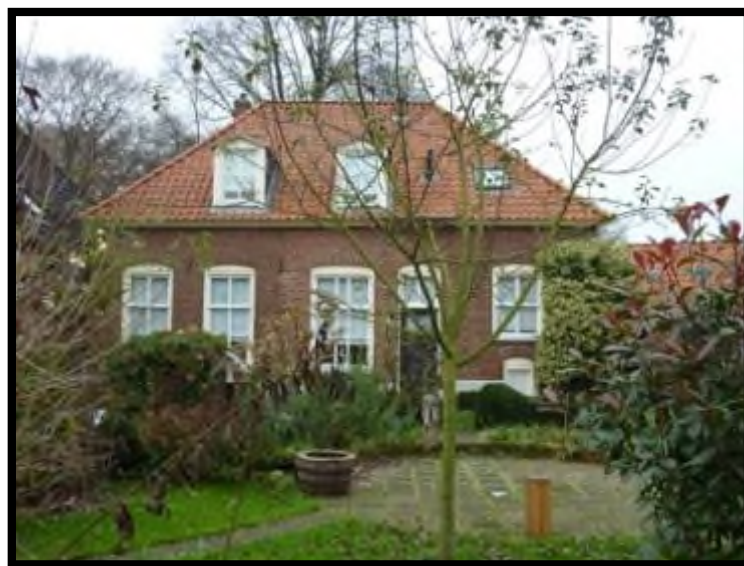
't Zand 11 achterzijde
