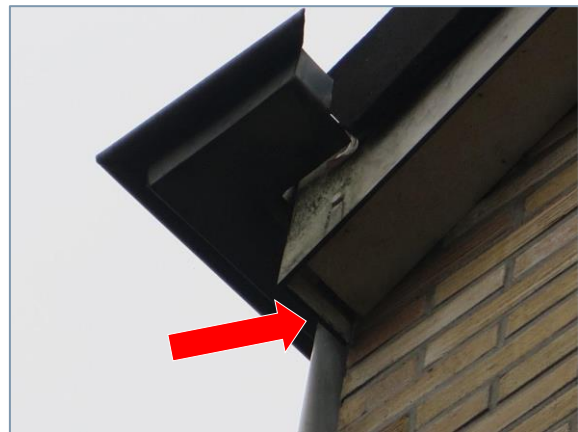
Foto 4. Ruimte achter dakrand zuidzijde gebouw (De Hoven).
