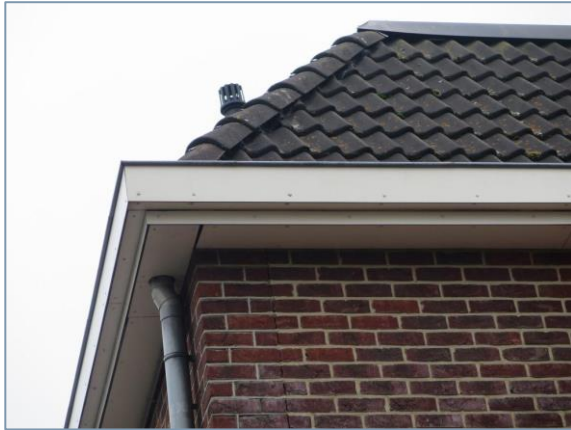
Foto 1. Detail dakgoot noordzijde gebouw (De Hoven).
