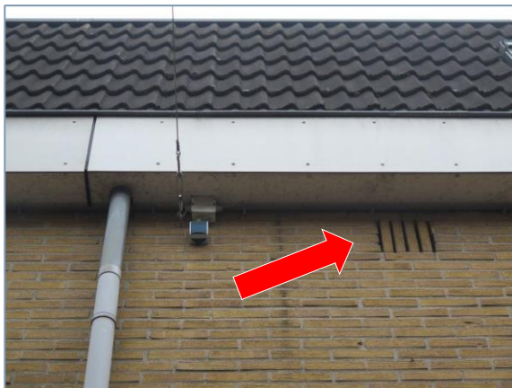
Foto 3. Ventilatie opening oostzijde gebouw (steeg tussen De Hoven en Hogestraat).
