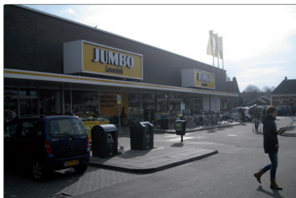
In de huidige situatie is ruimte voor uitbreiding
