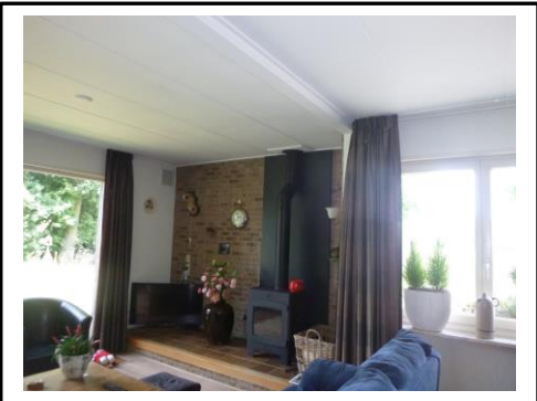
Vaste plafonds niet geopend
