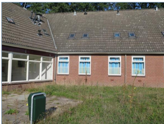
Foto 1. Wasgebouw met pannendak en dakgoot.
