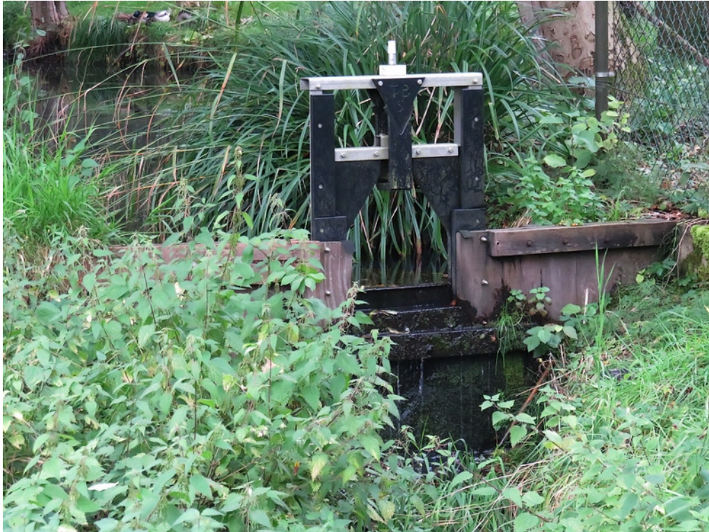
Foto 4. Het stuwte tussen de blusvijvers en de afwateringssloot. Het niveauverschil van de waterspiegel tussen beide wateren is ongeveer 50 cm.
