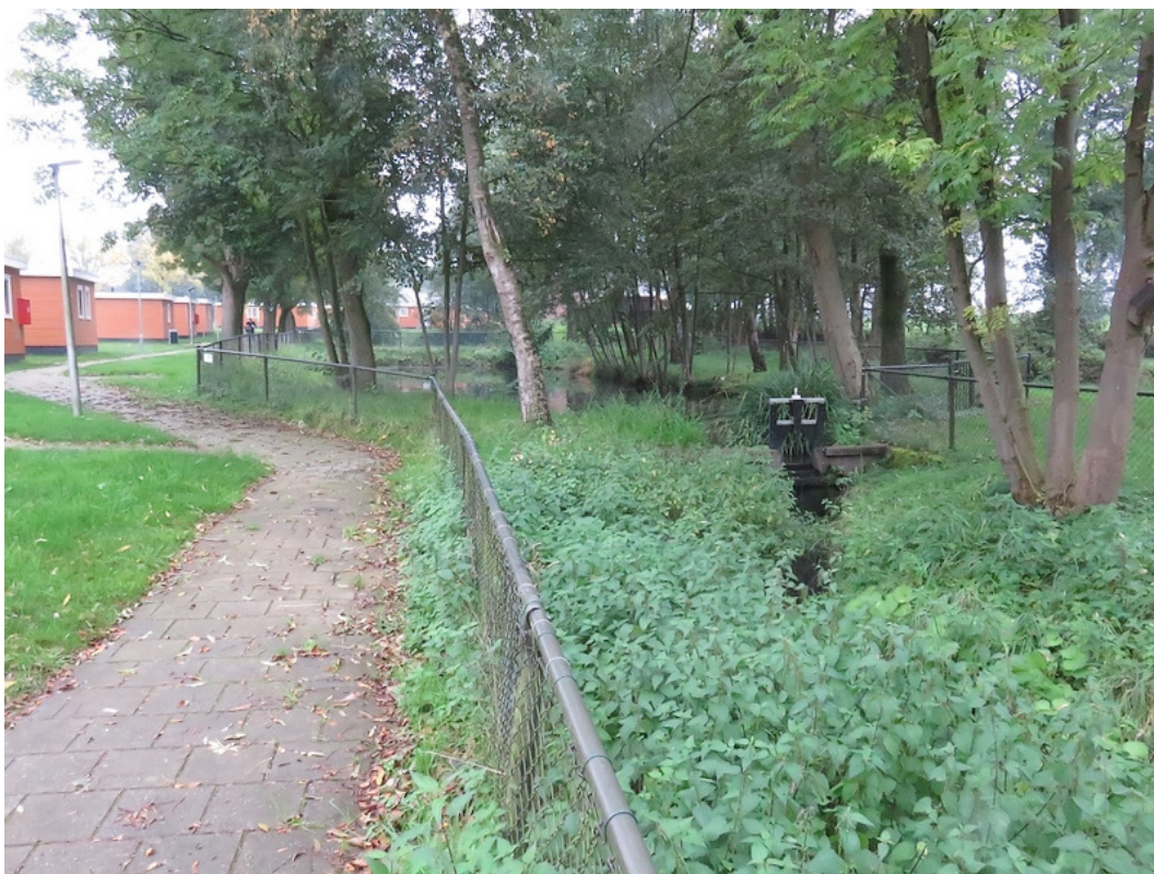
Foto 3. De aansluiting van de afwateringssloot op de blusvijvers.
