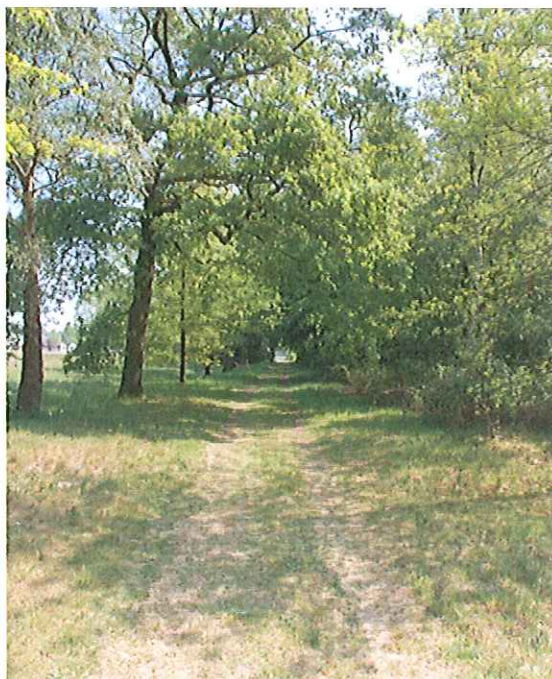
Zandpaden hebben een bol profiel. Om kuilvorming te voorkomen moet het zandbed droog blijven en dus goed afwateren.
