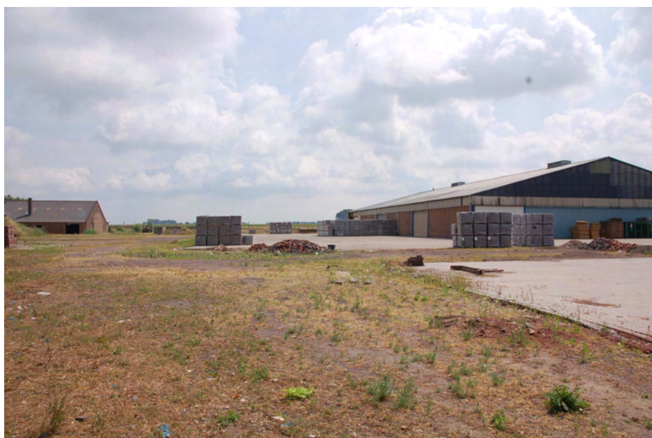
Figuur 3. Terrein Daams, met links het gebouw met verblijfplaatsen van gewone dwergvleermuis.
