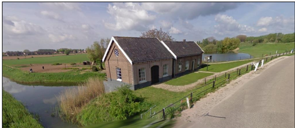
Huidige situatie zuidzijde Deukerdijk
