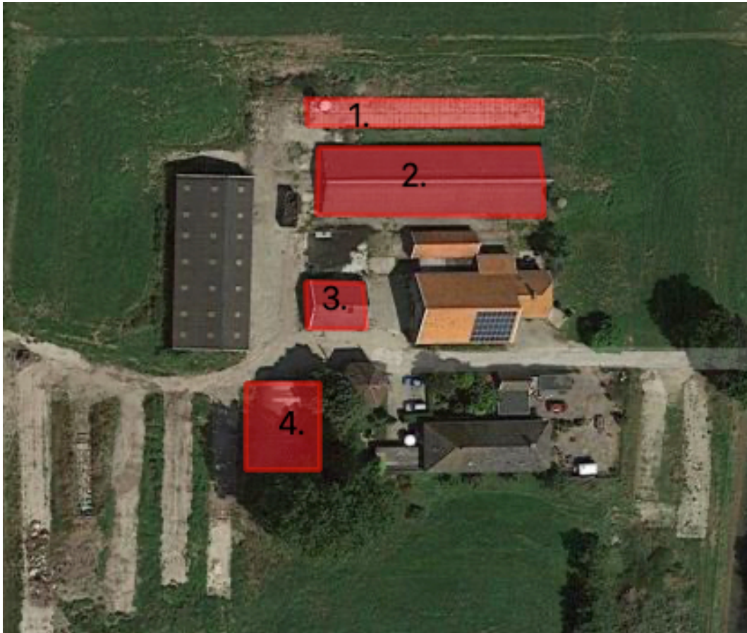
Afbeelding 2. Locatie plangebied (rood) ten aanzien van de te amoveren bebouwing. 1. Verharde mestplaats, 2. Voormalige ligboxenstal, 3. Schuur, 4. Loods. (Google Maps, sd)
