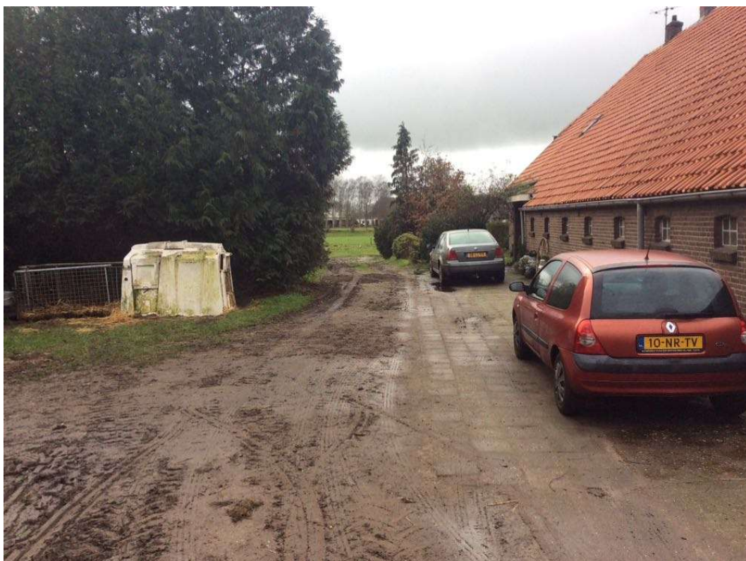
Puinpad E2 in zuidelijke richting, rechts op de achtergrond de voormalige ondergrondse tank A2
