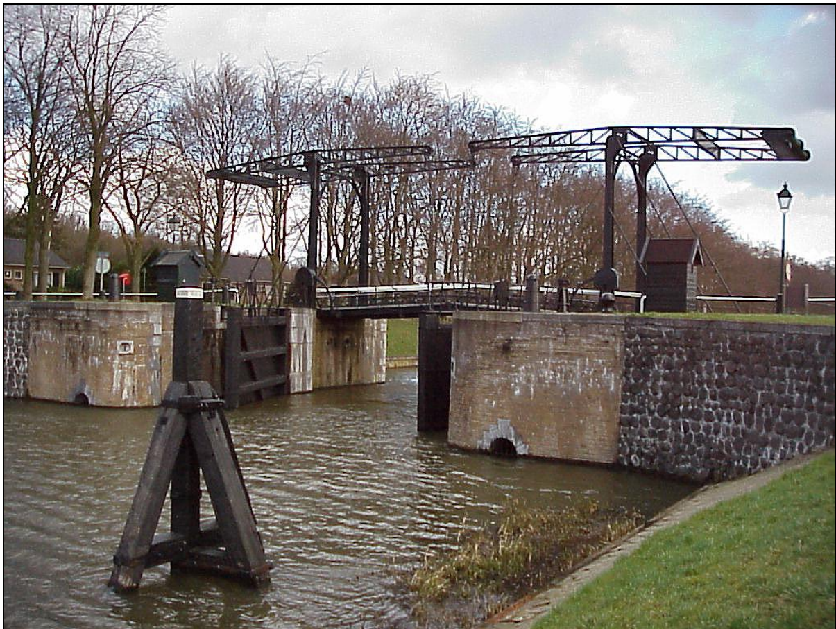
Sluisbrug over de Katerveersluis in de Willemsvaart.
