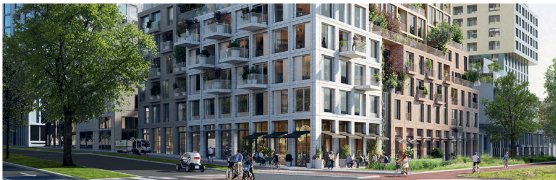
Geactiveerde hoge plint aan de Luttenbergstraat, balkons boven de plint
