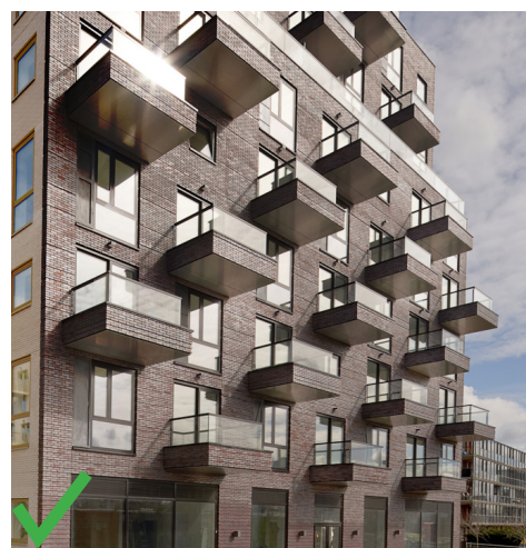
De plaatsing van de balkons heeft een helder patroon
