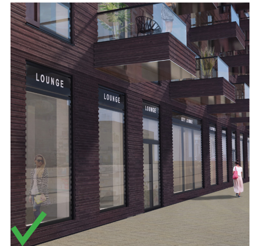
De signage is onderdeel van het kozijn en wordt niet op het hoofdmateriaal bevestigd.
