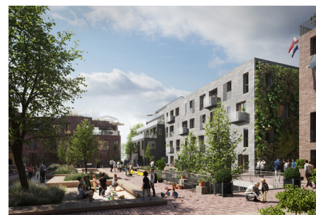
Bijzondere kopgevel uitgevoerd als groene gevel geeft de hoven een zachte uitstraling
