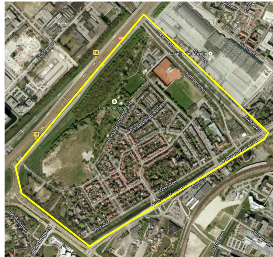
afb. 1 Luchtfoto plangebied, via googlemaps.
