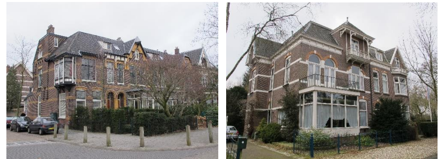
Afb. 21 en afb. 22 Geschakelde herenhuizen aan de Veerallee en de Strick van Linschotenlaan.
