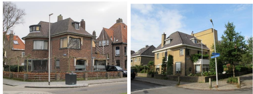
Afb. 23-26: Koningin Sophiastraat (links boven), Veerallee 51-52 (rechts boven), Oranje Nassaulaan 8 (links onder) en Koningin Wilhelminastraat 37 en verder).
