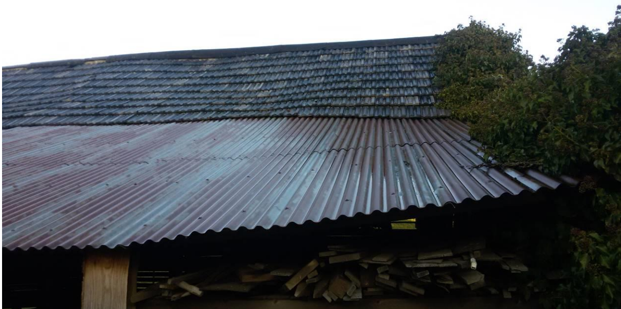
Figuur 3: Westelijke te slopen open loods, met pannendak zonder ondergrond en golfplaten. Geschikt als zomerverblijf of paarplaats voor vleermuizen.
