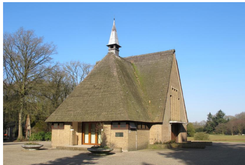
afb. 51 en 52 Boven het bouwhuis (rijksmonument) van de vroegere havezate Kranenburg. Beneden de uit 1933 daterende aula van de gelijknamige begraafplaats.
