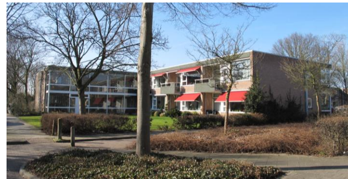
afb. 39, 40 en 41 Bovenaan het kerkgebouw aan de Campherbeeklaan 53. In het midden het winkelcentrum, en onderaan bejaardencentrum De Wissel.
