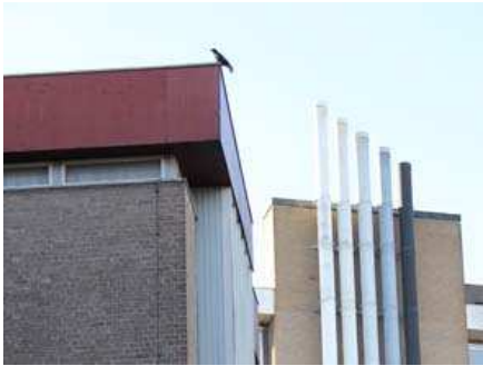
Foto 7. Daklijst van plaatmateriaal.
