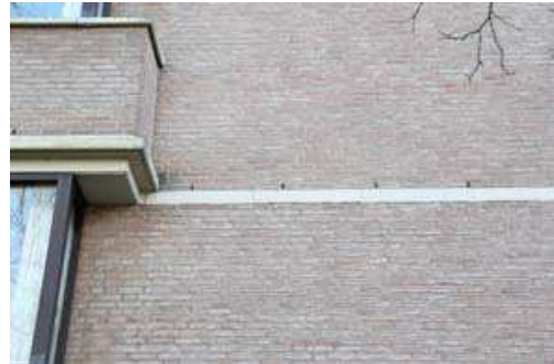
Foto 7. Gevel met open stootvoegen.
