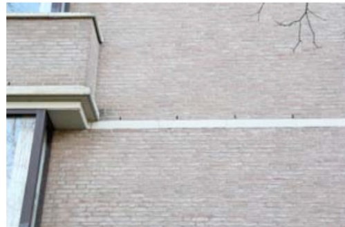
Foto 7. Gevel met open stootvoegen.
