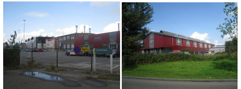
afb. 28, 29, 30, 31, 32, 33 Het tegenwoordige complex ter plekke van de vroegere spoorwerkplaatsen.
