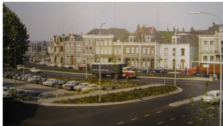
Afb. 91 Op de gedempte Willemsvaart nabij de Willemskade werd in 1968 een parkeerplaats aangelegd (foto Historisch Centrum Overijssel).
