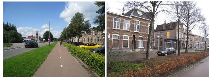
afb. 40, 41, 42, 43, 44, 45 Historische bebouwingrand van de wijk Assendorp. De grote herenhuizen in het westelijke gedeelte (Oosterlaan) worden gaandeweg verruild voor eenvoudiger rijen arbeiderswoningen aan de Deventerstraatweg.
