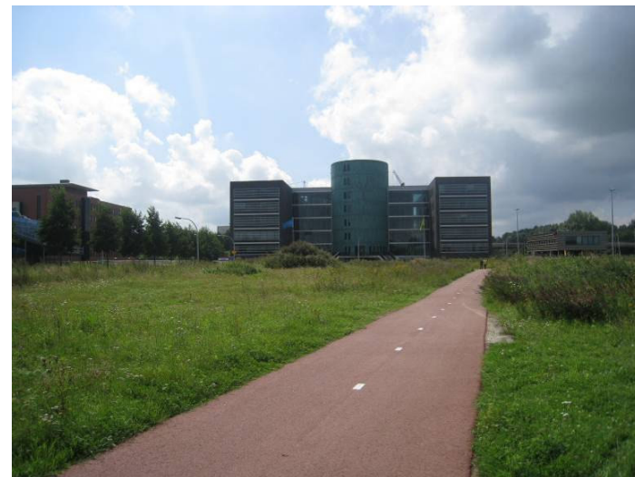
afb. 98 en 99 Moderne kantoorgebouwen in Hanzeland
