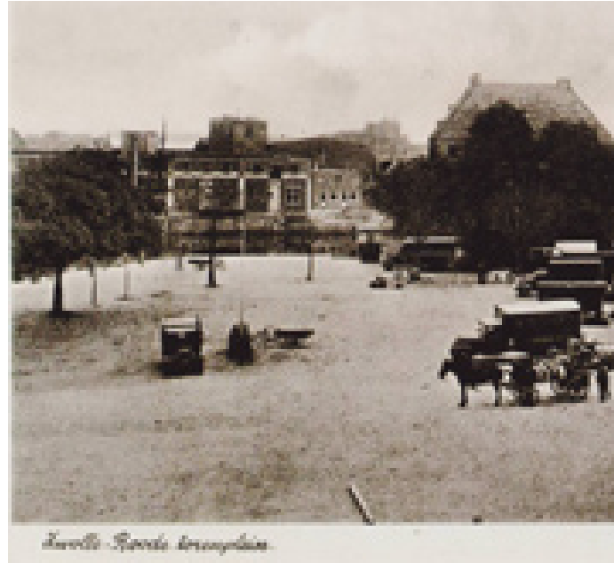
Overslaghaven op het Rodetorenplein, foto 1935
