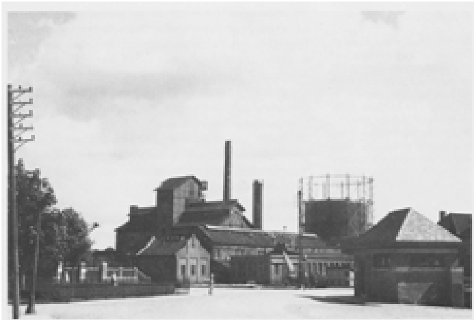
Gasfabriek op het Noordereiland
