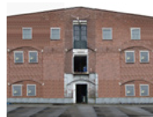
Reconstructie achtergevel, bureau Rein Geurtsen
