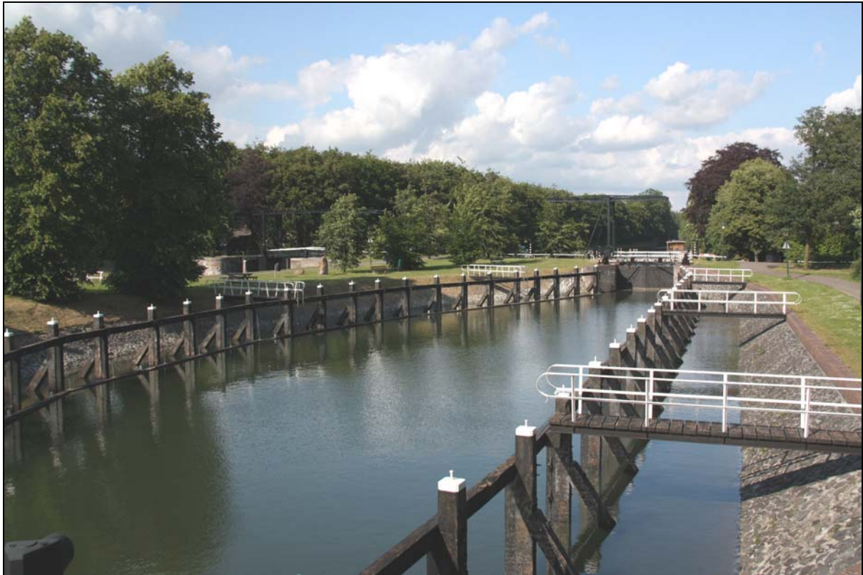
Sluiskom van de oude sluis bij Katerveer
