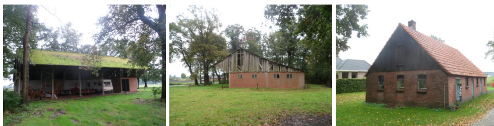
Foto's: Indrukken plangebied. De te slopen opstallen; kapschuur en stal.
