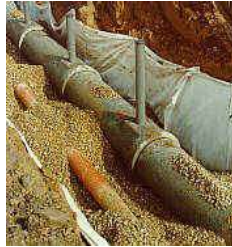
figuur 4.6 infiltratieriool (permeobuis)
