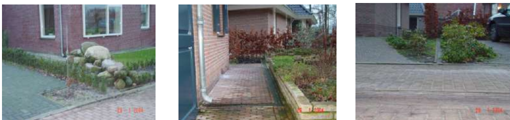
figuur 4.7 voorbeelden van afkoppeling HWA bij woningen
