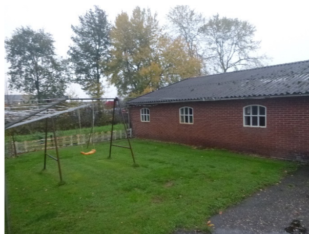
Dakgoot westelijke te slopen schuur
