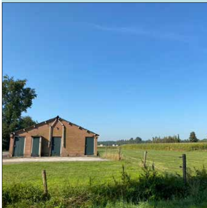
te slopen schuur langs de Rondweg
