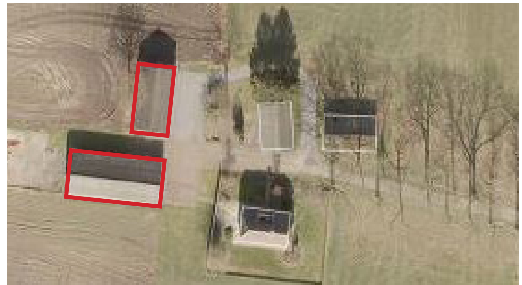
Figuur 10. Slooplocatie Hespelderweg - rood omcirkeld de te slopen gebouwen.
