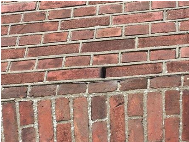
Open stootvoeg; deze opening kunnen vleermuizen benutten om een verblijfplaats te bezetten in de spouw.
